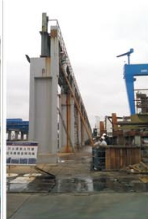
兄弟们，扶稳了呀！ ——中远设备安装现场
