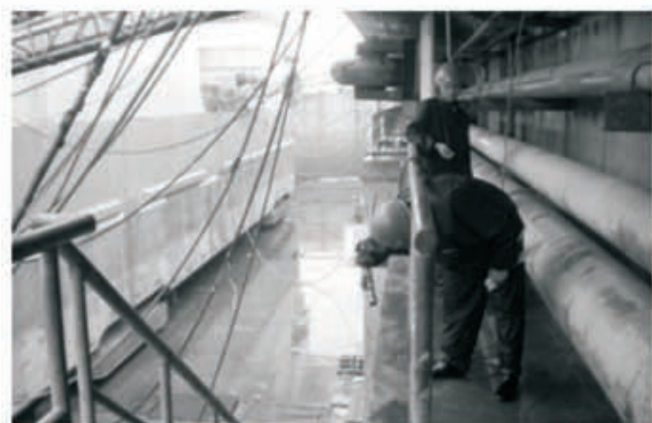
图二：船上施工现场
