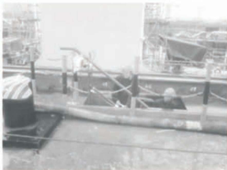
图四：启东设备安装，时间较紧冒雨安装
